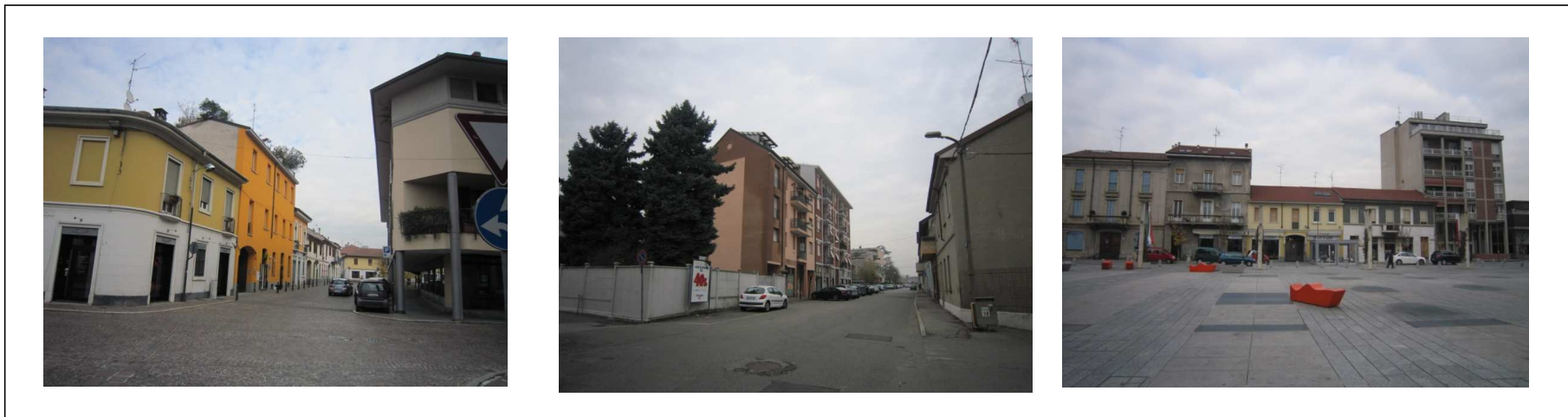
Esempi di cortine incoerenti sia nell'impianto volumetrico che nei caratteri architettonici
