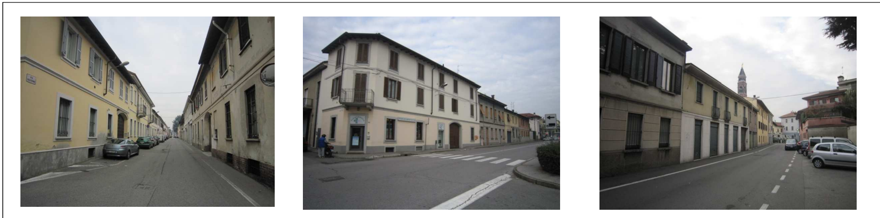
Esempi di cortine coerenti sia nell'impianto volumetrico che nei caratteri architettonici
