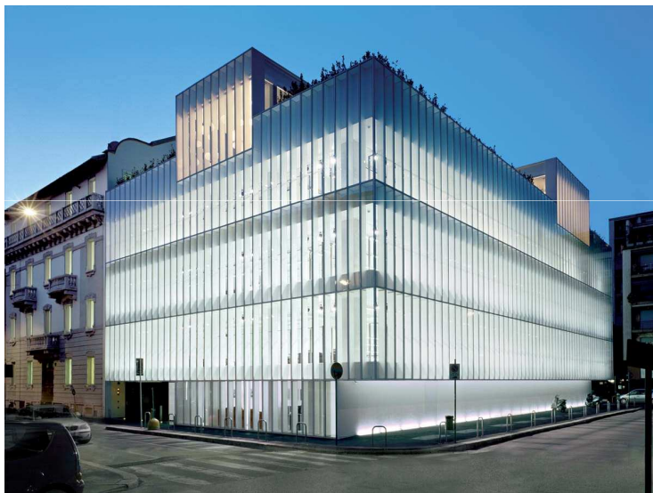
Piurarch | uffici Dolce & Gabbana | Milano - 2006
