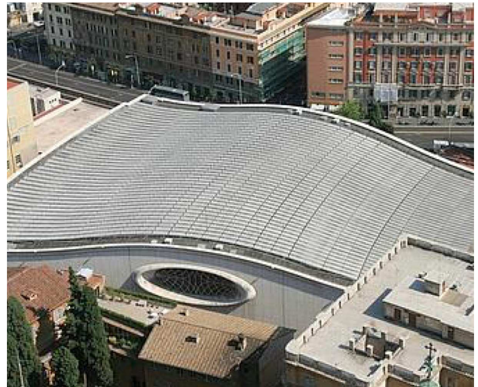
Impianto integrato seguendo il profilo originario della copertura Aula Paolo VI - Città del Vaticano
