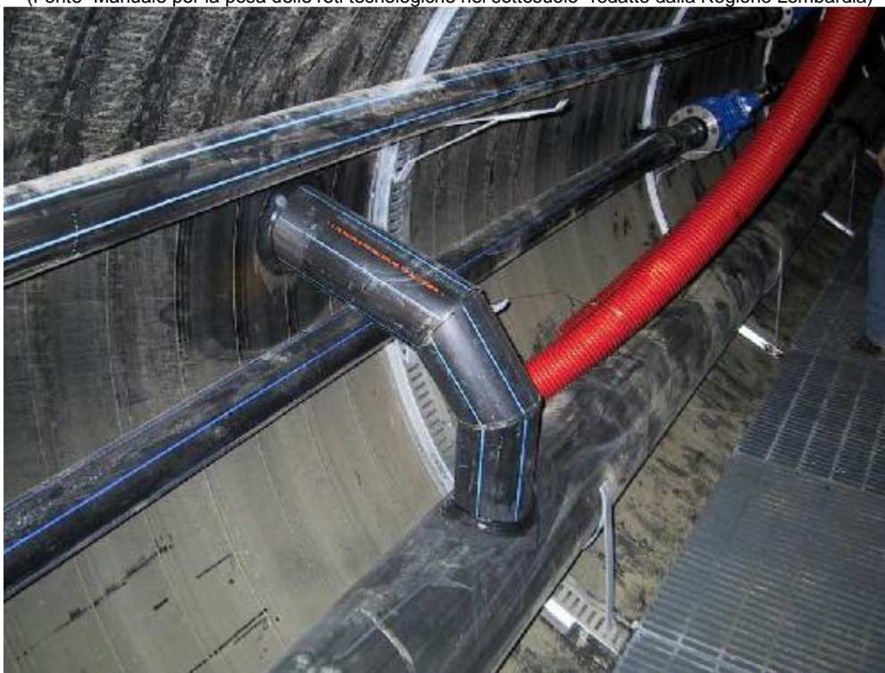
Galleria tecnologica-derivazioni per allacciamenti alle utenze (Fonte "Manuale per la posa delle reti tecnologiche nel sottosuolo" redatto dalla Regione Lombardia)
